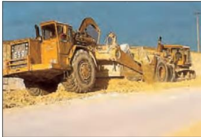
Le motor-scraper est l'engin d'extraction en couches minces par excellence.
