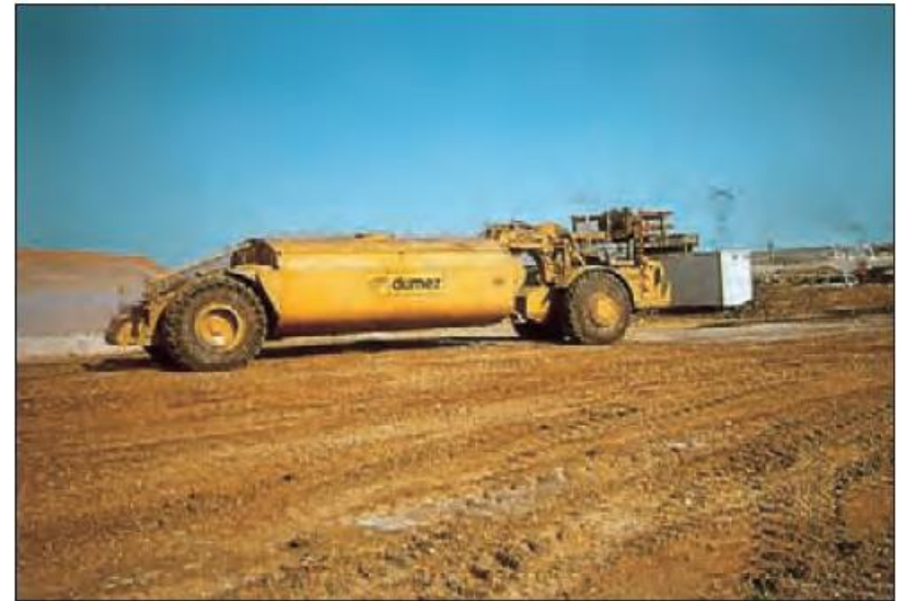
L'humidification des sols trop secs nécessite d'approvisionner de grandes quantités d'eau (souvent plus de 100 litres d'eau par mètre cube de sol) comme le montrent les imposantes dimensions de l'arroseuse représentée sur la photo (100m 3 )
